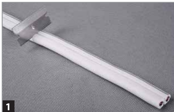
1. Odstraňte asi 16 cm izolace z konce kabelu.
